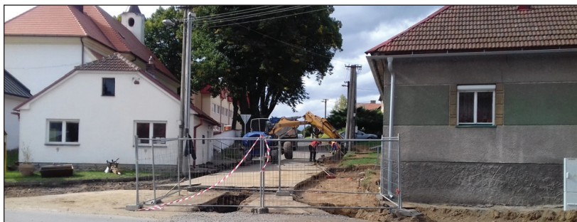
rekonstrukce vodovodu a kanalizace na náměstí
