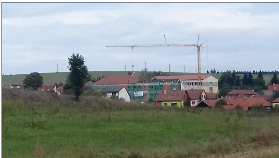
Probíhající investiční akce - Stavební úpravy ZŠ a MŠ Radostín nad Oslavou
