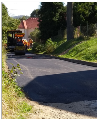
Dokončená rekonstrukce kanalizace
