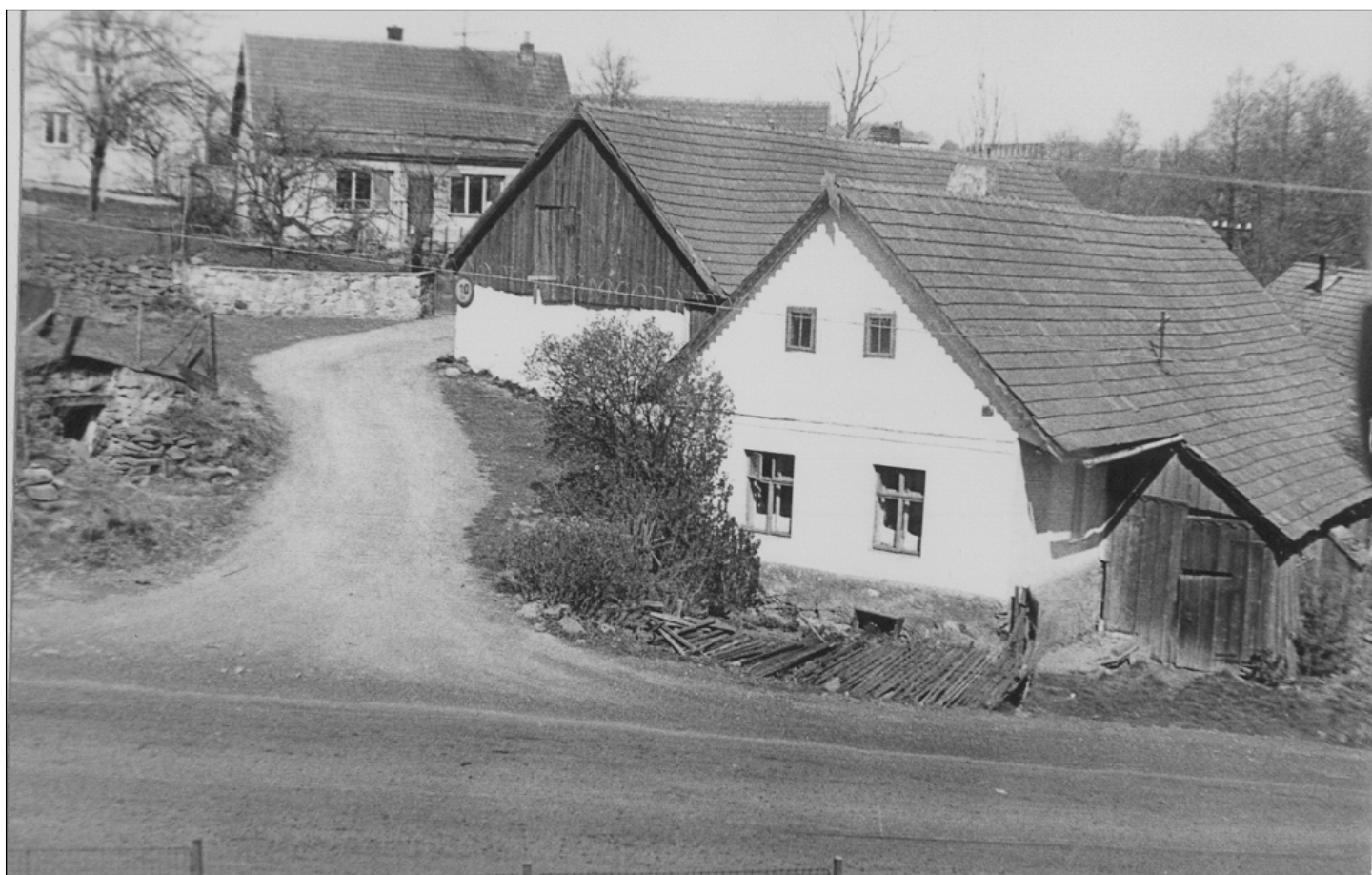
bývalý dům čp 2
